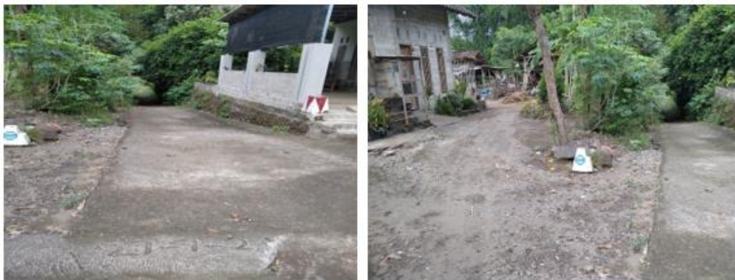
Gambar 5. Kondisi Jalan dan Rumah Menuju DAS
